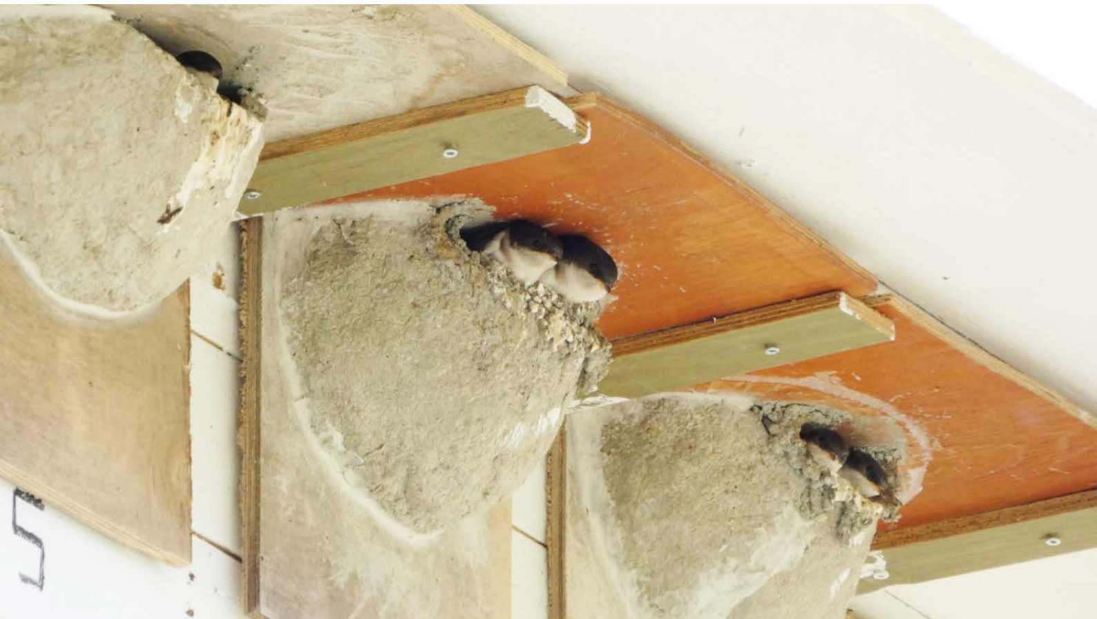
Betonista valmistettuja räystäspääskyn tekopesiä. Kuva: Raimo Henriksson.
