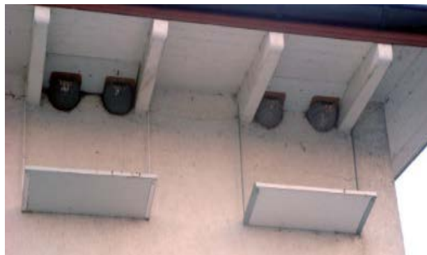
Pääskynpesien alle asennettuja, ulosvedettäviä uloste-suojalevyjä. Kuva: BirdLife Sveitsi.
